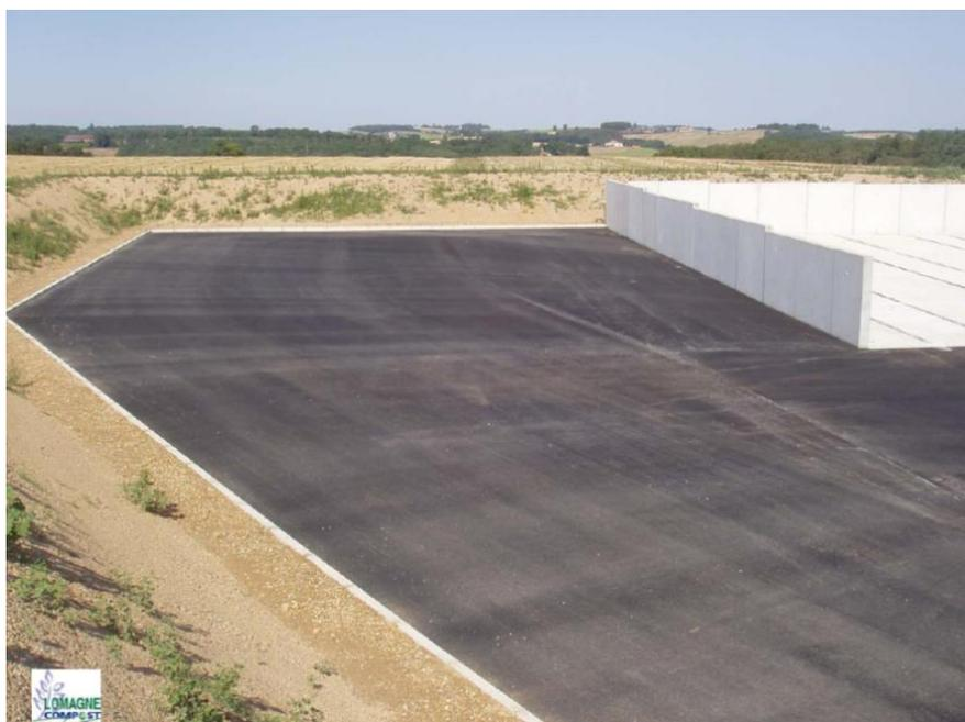
Figure 2 : Zone de réception, broyage et stockage des co-produits en enrobé
