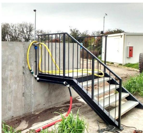
**Figure 10 : Aire de lavage des engins et passerelle surélevée**
