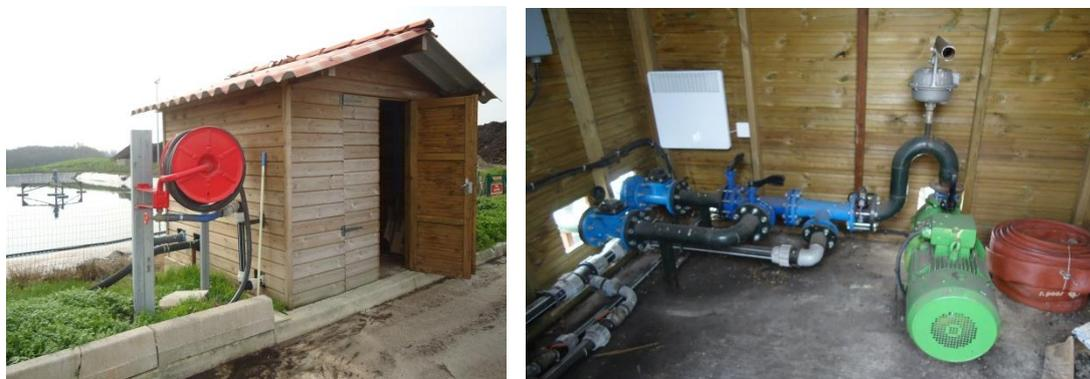
Figure 9 : Système de pompage des eaux de la lagune
