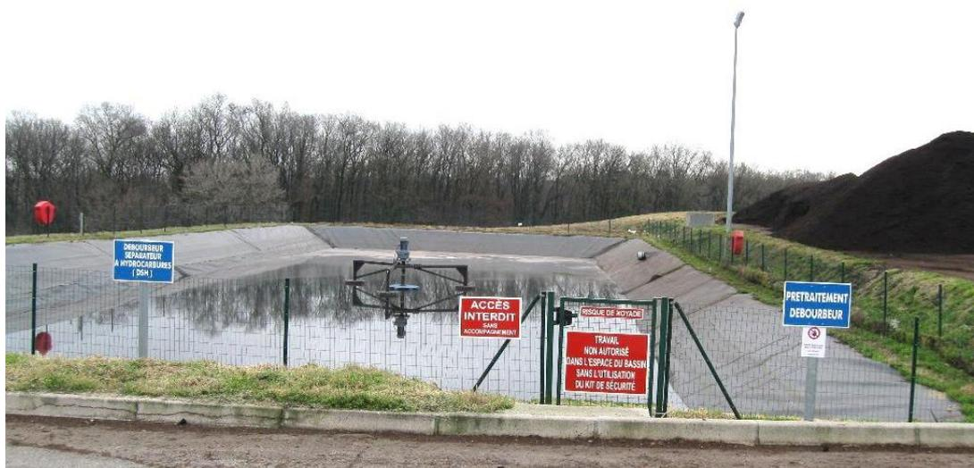
Figure 8 : Lagune étanche et clôturée de collecte des eaux résiduelles du site
