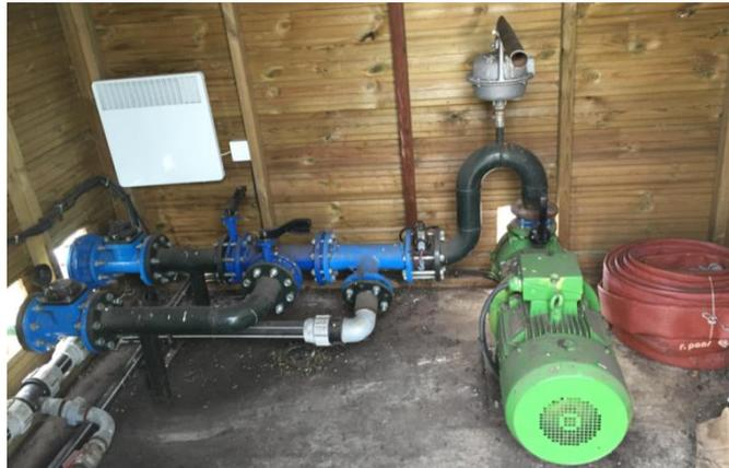
**Figure 19 : Dispositif de pompage et de mesure des eaux résiduaires**
