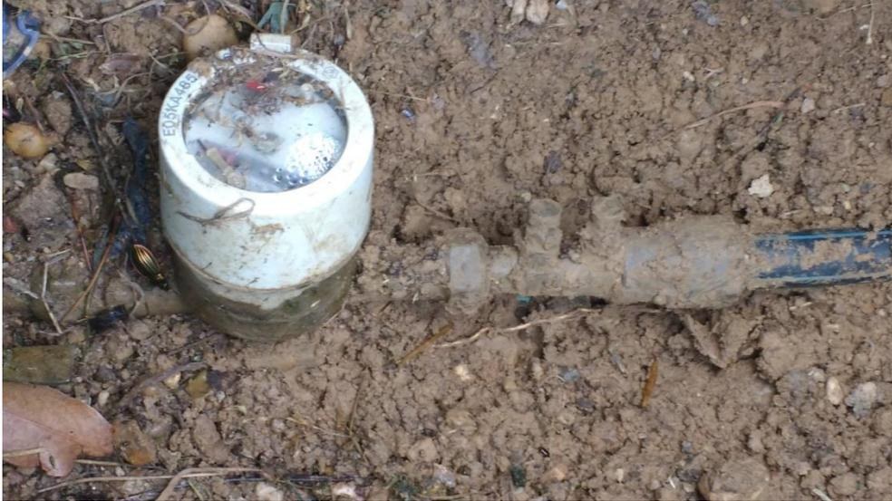
**Figure 17 : Compteur d'eau potable et clapet anti-retour**
